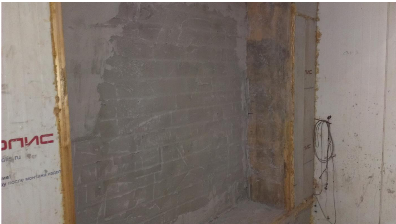
Рис. 7. Фрагмент стены после завершения кладки в один кирпич.
